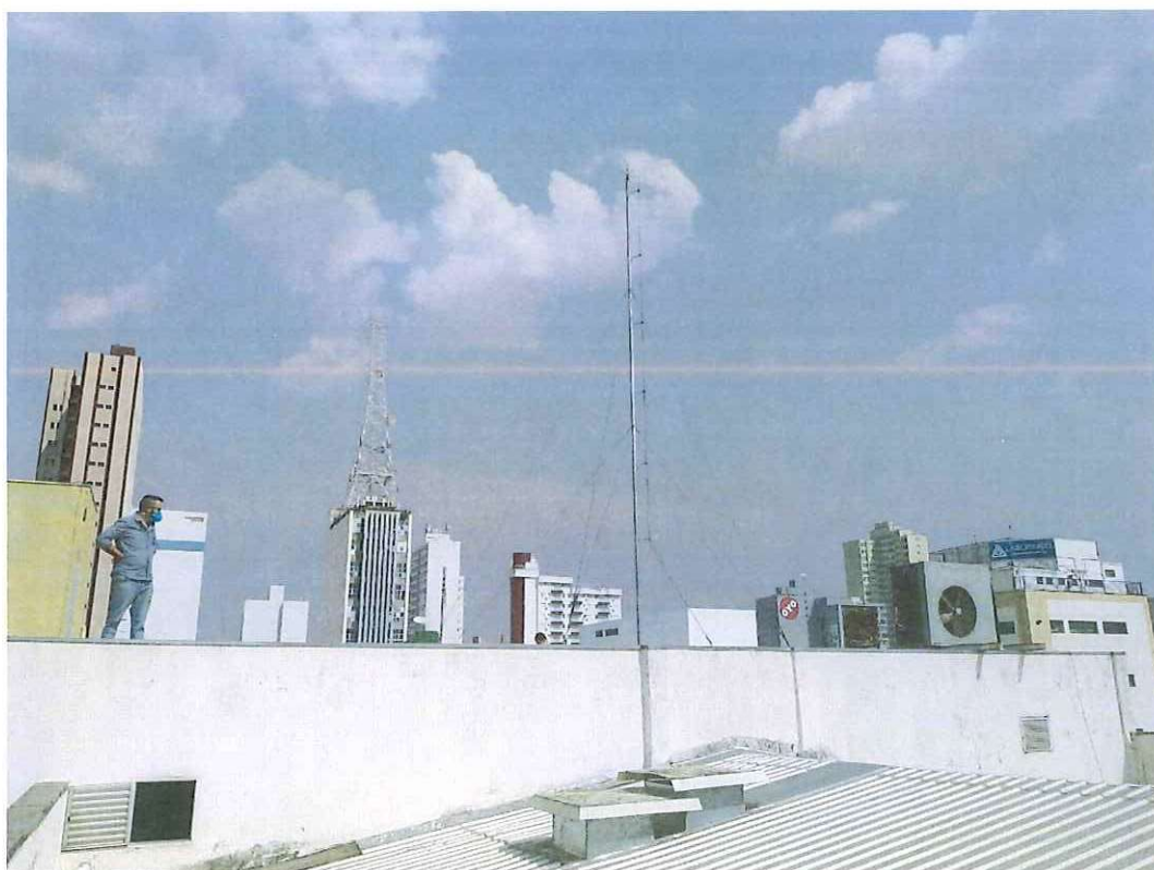
Foto 2 – Captor Franklin instalado no telhado do hospital.
